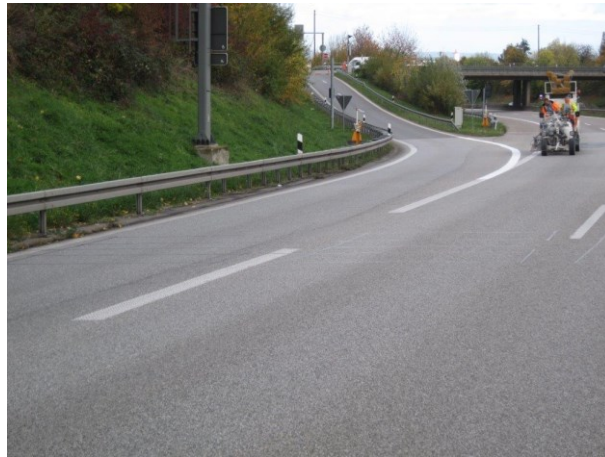
Vorher - Nachher: Bild 1 Einfahrt, alte Markierung.
