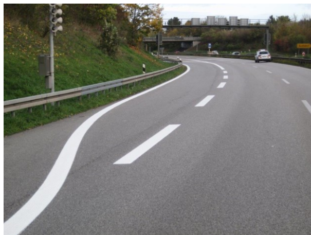
Bild 3. Bis zur Ampel verlängerte Einfahrt, mit gestrichelter Linie fürs Einfädeln. Bilder Straßenmeisterei Weinstadt/ Bihlmeier.
